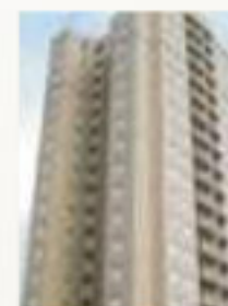
Edifício Cambiar Perla
