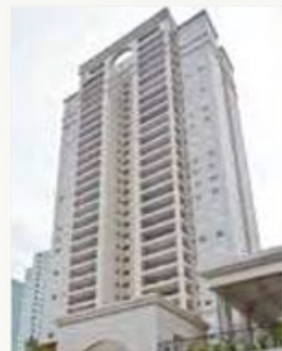
Edifício Fênix Santana
