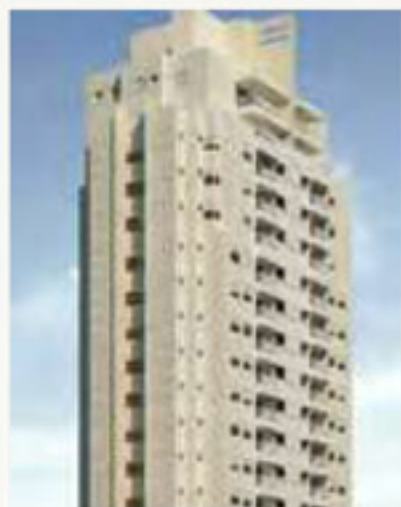
Edifício Vergil Perleux
