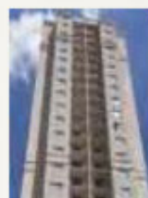
Edifício Connect Sacombi
