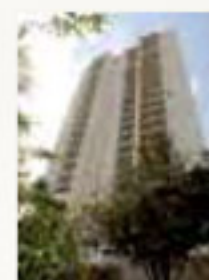
Edifício Abdur Jundiaí
